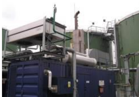
Chlazení vyvedené nad kogenerační jednotku
